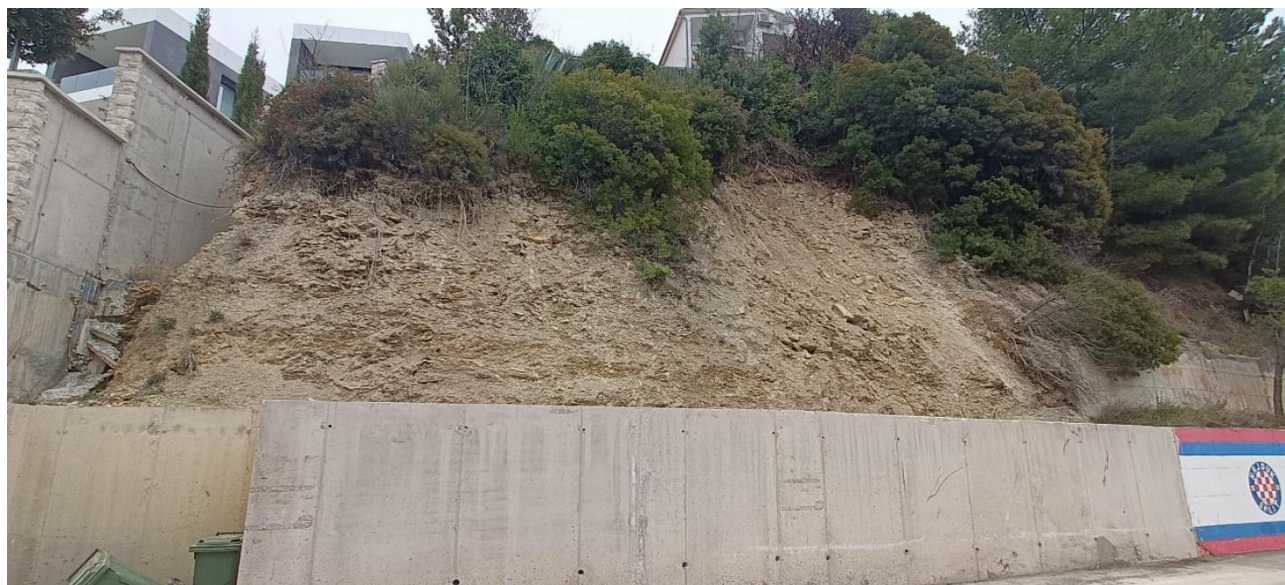
Slika 3 - Pogled na pokos nakon izvršenog čišćenja
